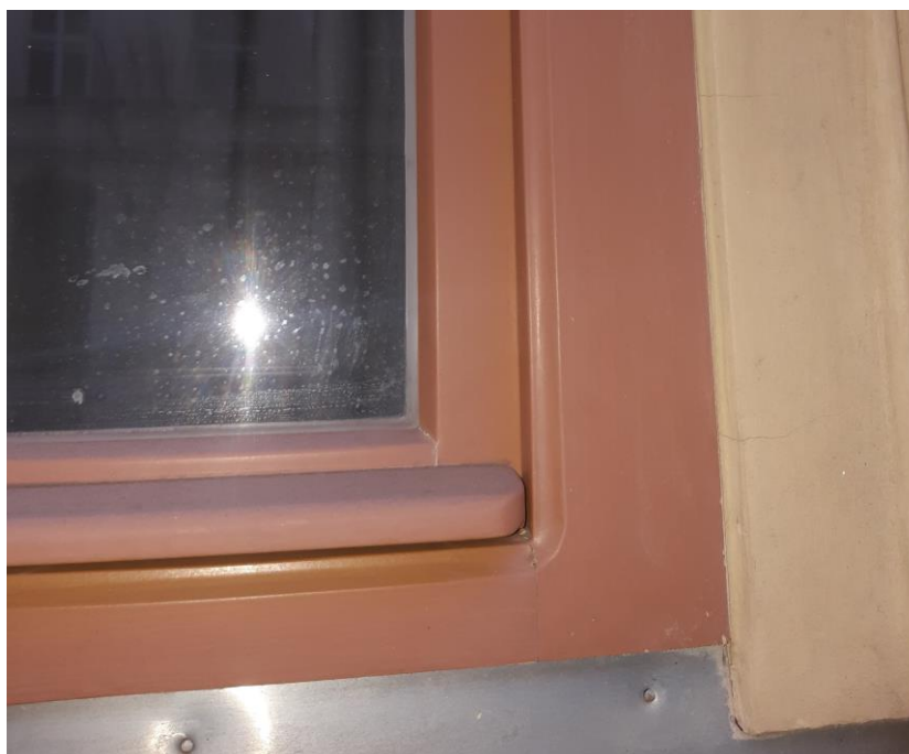
Obr. 2 – Vzor frézování rámu
